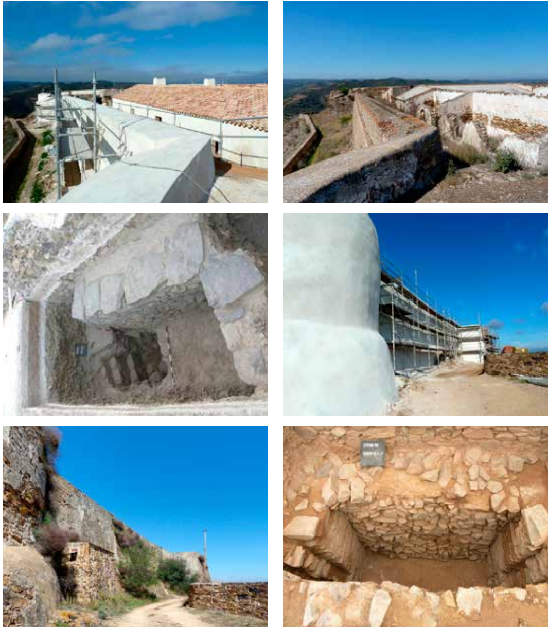
Figura 7. Fotografías generales del castillo de San Marcos de Sanlúcar de Gadiana antes y durante la restauración en curso de ejecución
