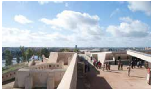
Figura 5. Fuerte de San Cristóbal rehabilitado
