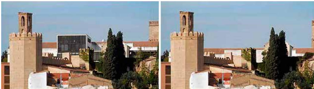
Fig. 6: Ampliación para la Facultad de Biblioteconomía de la UEX.
