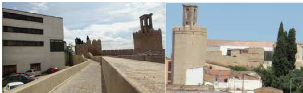
FIG. 24. Badajoz. Imposición en la Alcazaba de edificio de la Facultad de Biblioteconomía y derribo. (Desmontaje: verano 2016)
