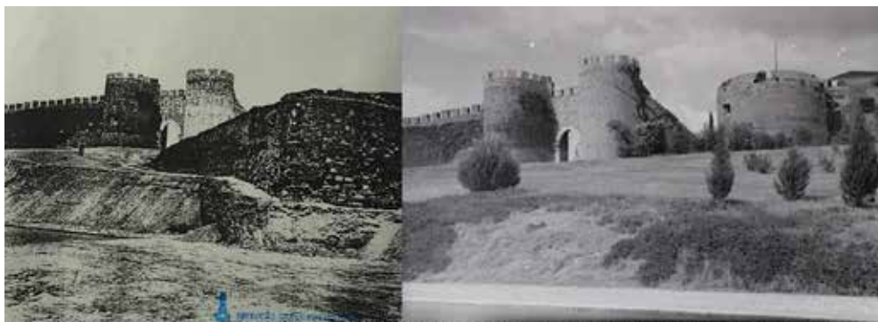
VILA VIÇOSA. 1. Reconstrucción de las Puertas de Évora (1942) con persistencia de revellín. 2. Eliminación de revellín, con visión del castillo artillado en actuación inmediata. (La arboleda actual impide ver el castillo)
