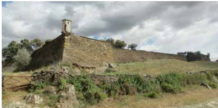
FIG. 16. Alcántara. Abandono de elementos fortificados exteriores.
