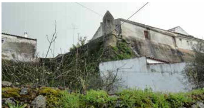
FIG. 20. Arronches. Colmatación de espacios interiores y superiores de la muralla.
