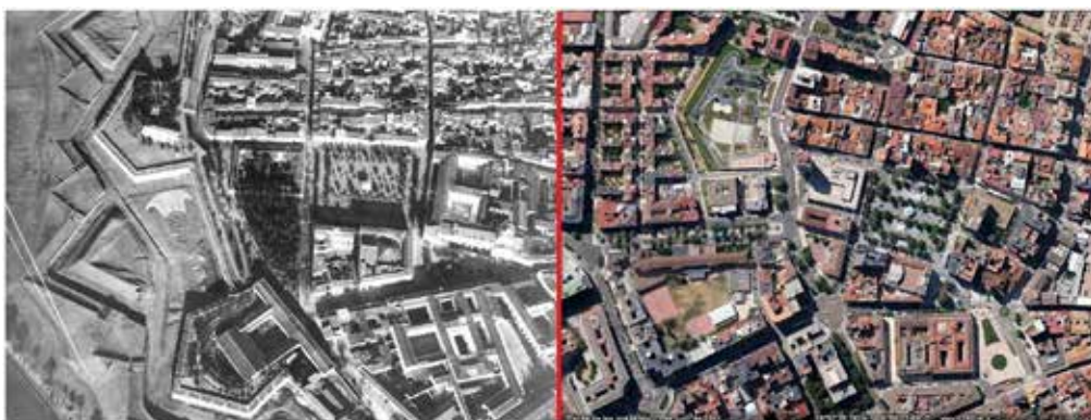
BADAJOZ. Foto de la izquierda, desde globo en 1914: arriba, baluarte de San Juan; abajo, baluarte de Santiago (con Cuartel de La Bomba en el interior); tras la cortina, Cuartel de Ingenieros y parque urbano; delante, revellines y glacis. Foto de la derecha, Google 2011: arriba, baluarte de San Juan; desaparecen el baluarte de Santiago, los cuarteles, revellines y glacis, pasando a colmatarse los espacios con viviendas de expansión en los años sesenta a ochenta del siglo XX. En el flanco izquierdo del baluarte de San Juan se instala en su interior un Museo del Carnaval, simulando al exterior un remate artificioso en parte de la gola.
