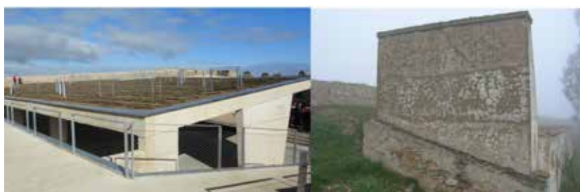
FIG. 33. Terrazas inapropiadas en el Fuerte sustituyendo a tejado con chimenea.
