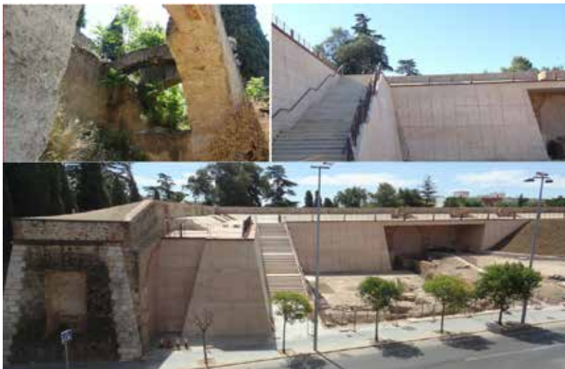
FIG. 34. Badajoz. Actuación sobre el Baluarte de la Trinidad.
