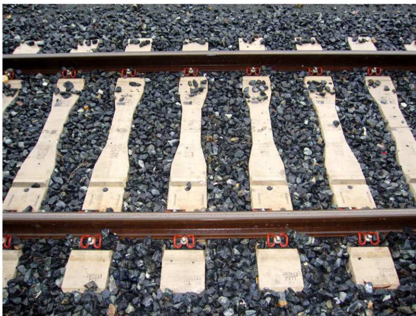
Figura 28. Traviesas de 3 carriles AM-05 en la estación de Vilagarcía de Arousa (sólo se han colocado los carriles correspondientes al ancho ibérico).
