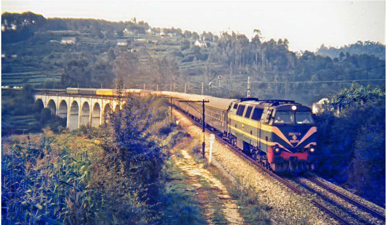
Figura 37. Expreso Rías Bajas Madrid – Vigo a su paso por el viaducto de Saxamonde (1984). Fuente: B. Figueroa.
