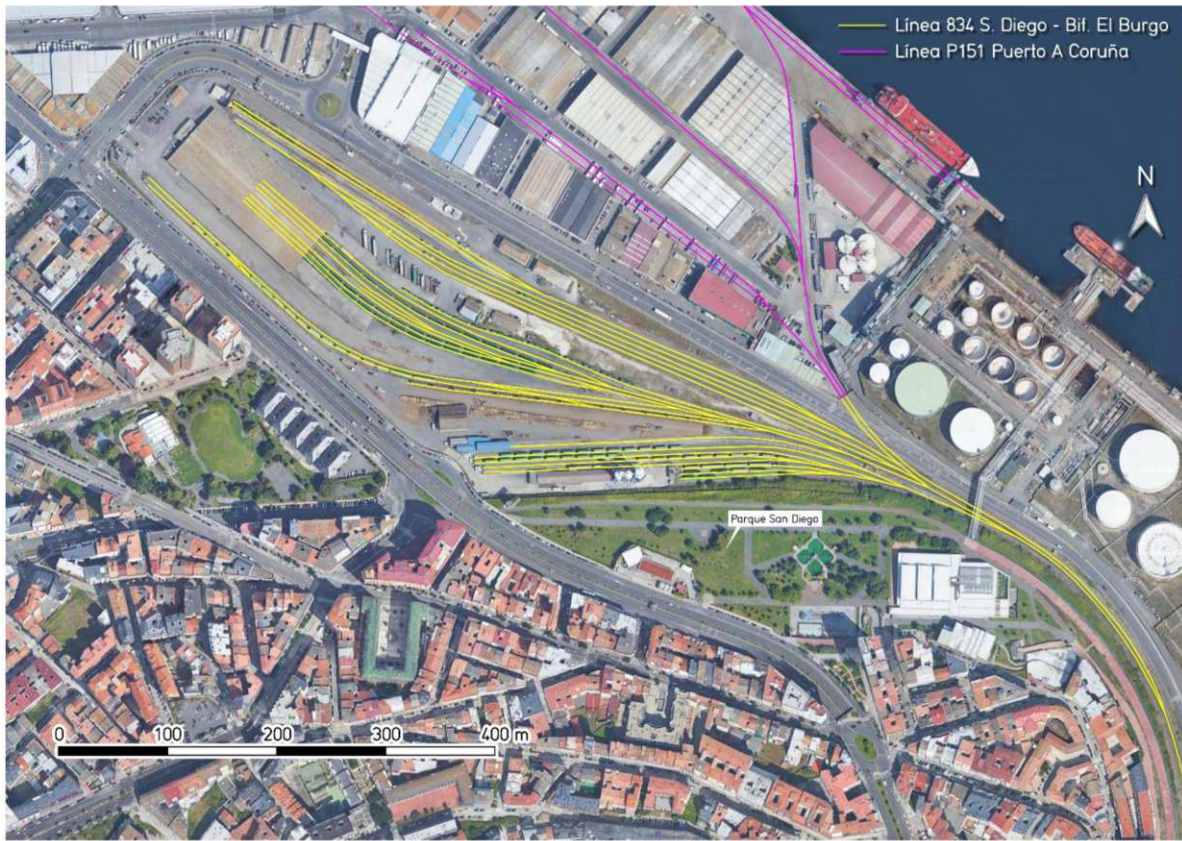
Figura 21. Playa de vías de la terminal de mercancías de A Coruña – San Diego.
