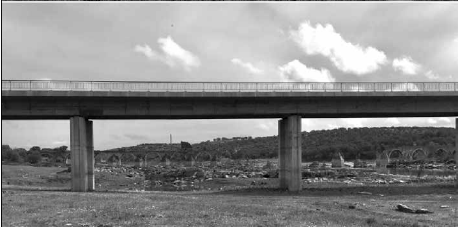
Ponte de Ajuda y nuevo puente aguas abajo del destruido. (MCR)
